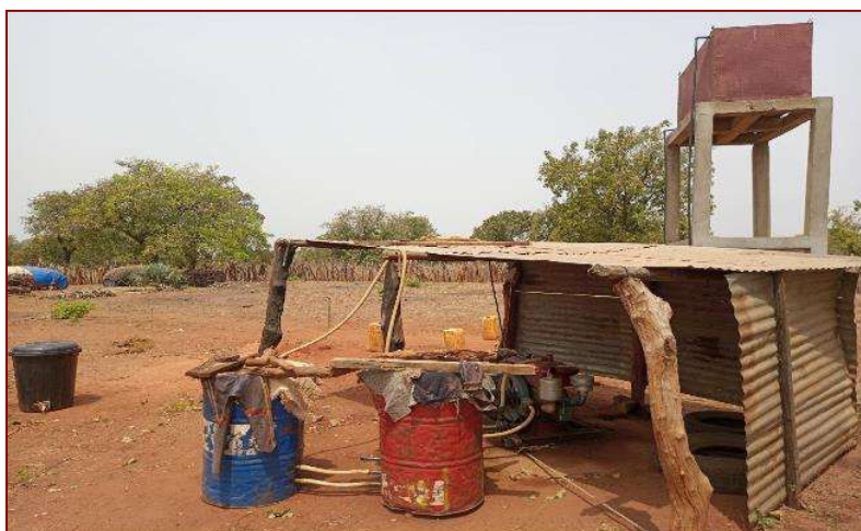
Un château d'eau construit sur initiative et fond propre des agropasteurs sédentarisés. Une stratégie de résilience aux effets du changement climatique afin de palier à la pénurie chronique d'eau. Photo Passirina. 02/21.
